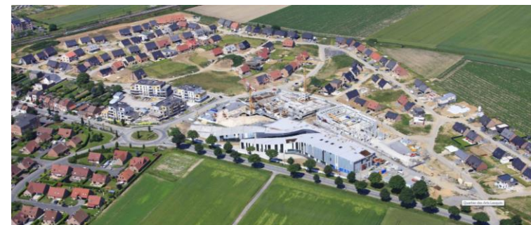
Vue aérienne du chantier
